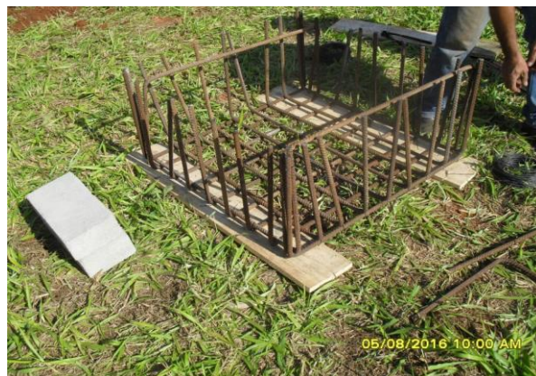
FOTO 18 PREPARAÇÃO DA FERRAGEM DA FUNDAÇÃO
