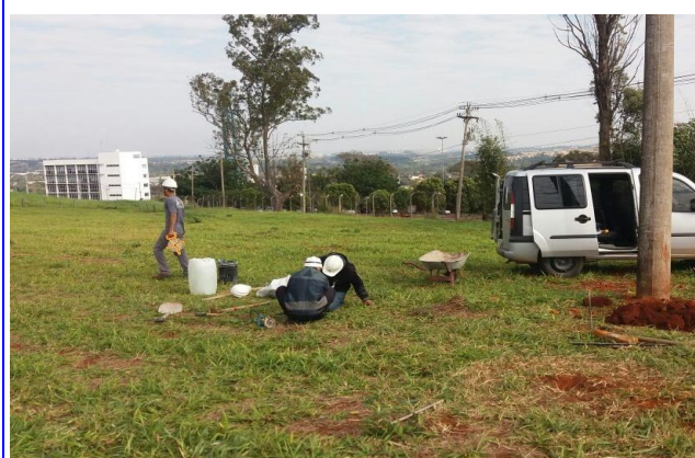
FOTO 05 ESCAVAÇÃO PARA BASE DO CONTAINER
