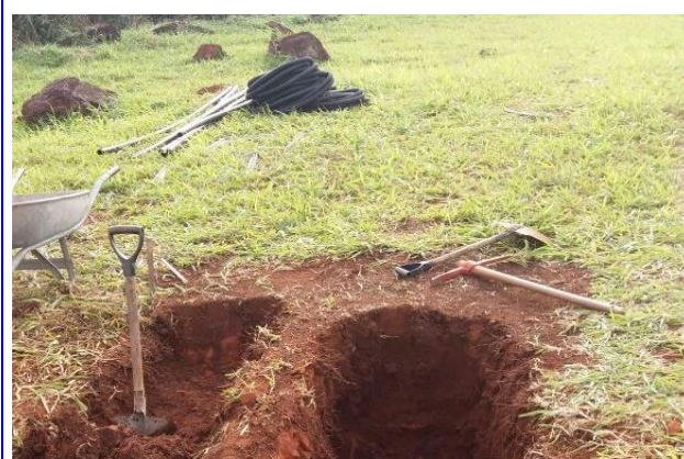
FOTO 06 ESCAVAÇÃO PARA CAIXAS DE PASSAGEM
