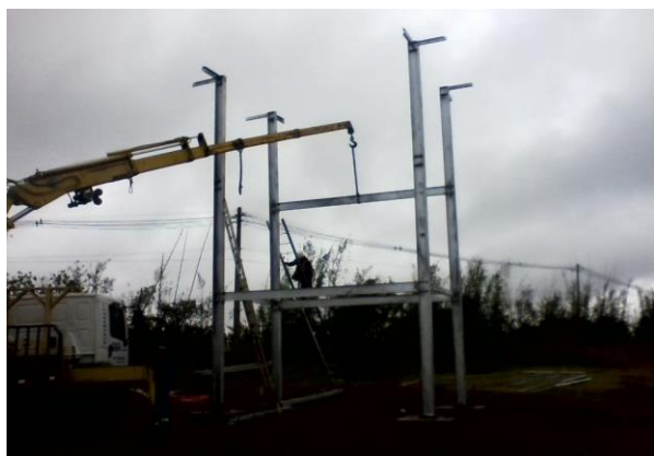
FOTO 37 MONTAGEM DA TORRE
