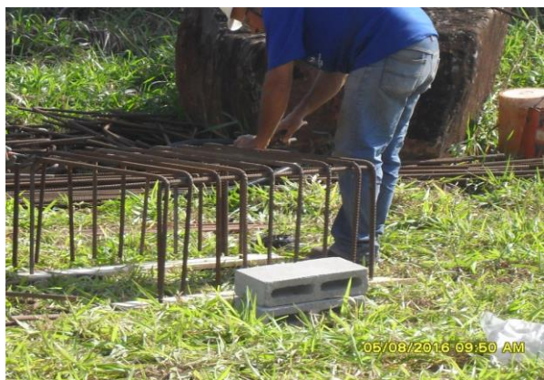
FOTO 17 PREPARAÇÃO DA FERRAGEM DA FUNDAÇÃO
